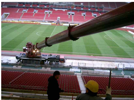
Einsetzen der Fertigteilrangstufen in der Gegentribüne
